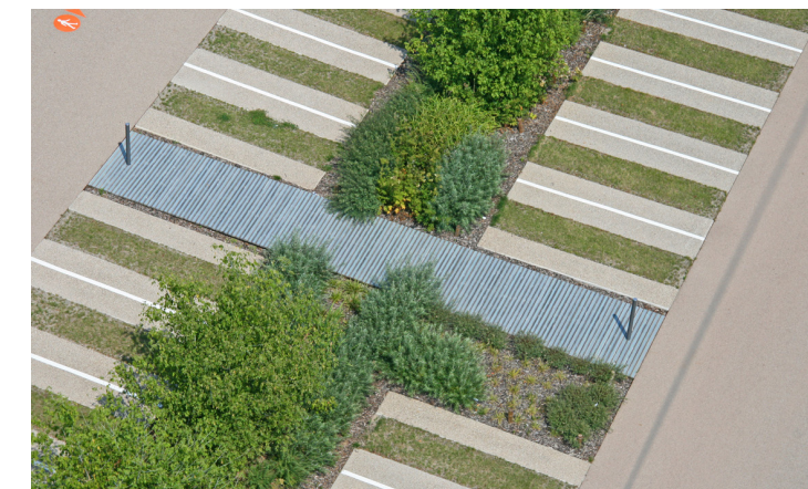
Références de traitements des parkings : surfaces imperméables minimisées et végétalisation (Parking du Zénith de Strasbourg)
