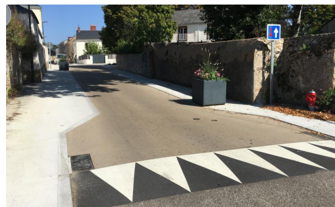
Plateau ralentisseur et mise à niveau de la chaussée
