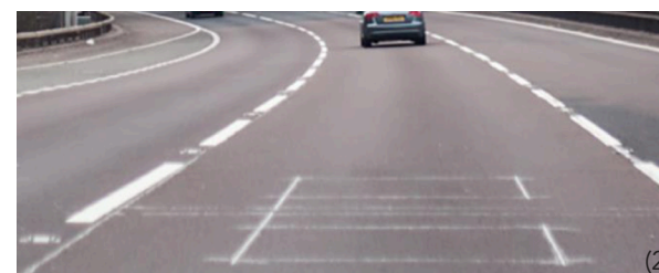
Références de dispositif de jalonnement dynamique - affichage du nombre de places restantes (capteurs à la place (1) ou boucle inductive en saignée dans la chaussée(2))
