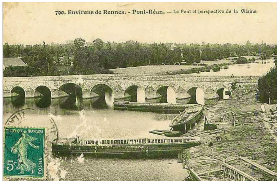
Chantier de construction de cahot, Pont Réan, début XXème siècle / Site des amoureux de la Bretagne, Jules Michel Chartier
