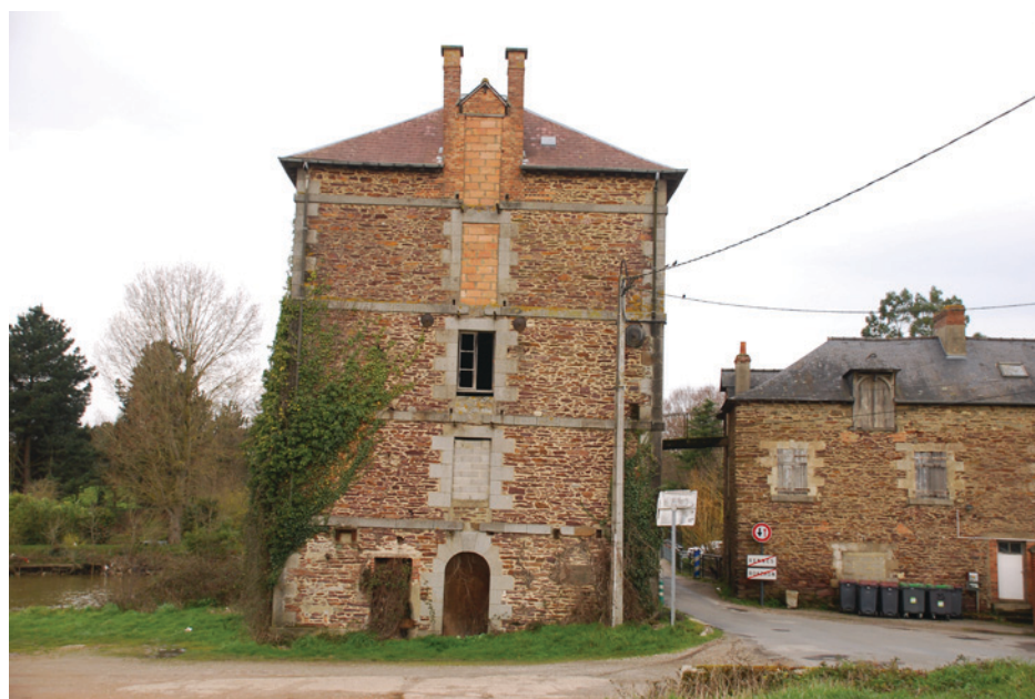
Moulin d'Apigné, façade en schiste du Boël / © Agence Ter
